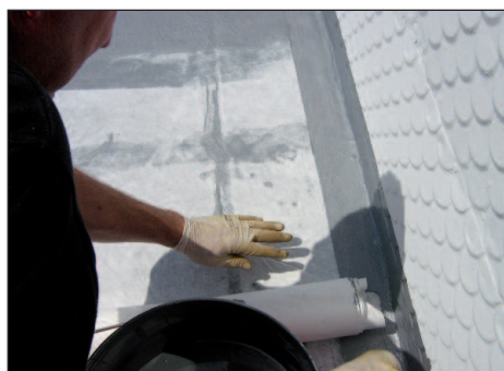
Enkopur-Abdichtung mit vollflächiger Enke-Polyflexvlieseinlage
