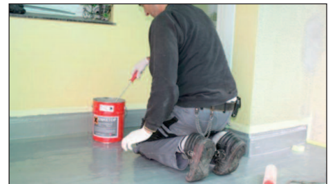
Aufgehende Wandanschlüsse mit Enketop streichen
