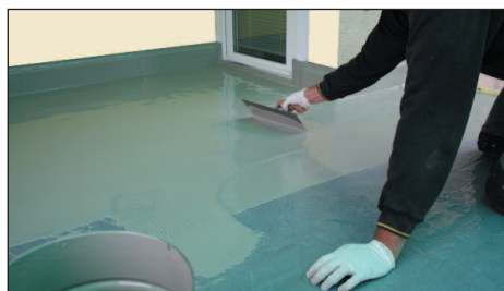
Gleichmäßiger Auftrag von Enketop mit der Zahnkelle
