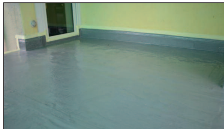
Vor dem Aufbringen von Enketop muss die Enkopur-Abdichtung durchtrocknen
