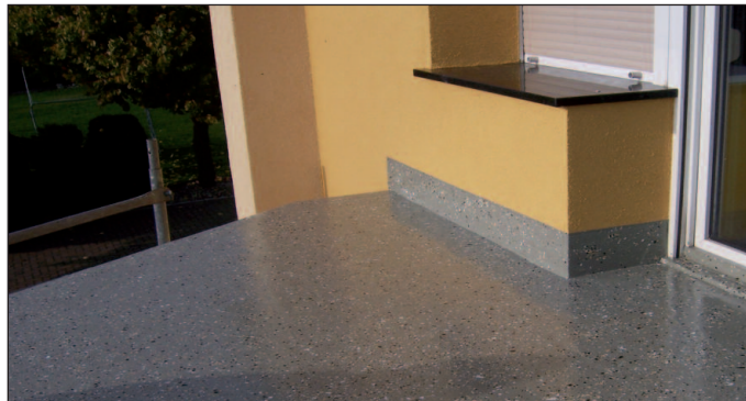
Partielle Abstreuerung mit Enke Kunststoffchips
