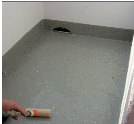
Auftrag der Enketop Versiegelung mit der Veloursrolle
