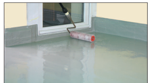
Entlüften der Enketop - Beschichtung mit der Stachelwalze
