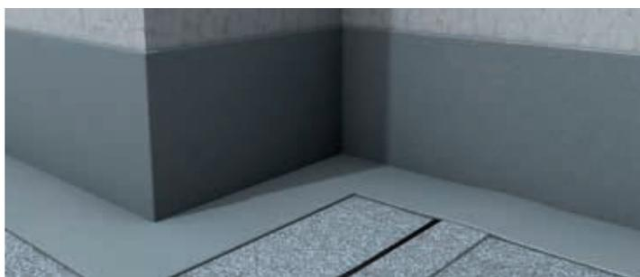
**5.** Nach der Applikation das Abdeckband sofort, im noch nassen Zustand des Abdichtungsharzes entfernen.
