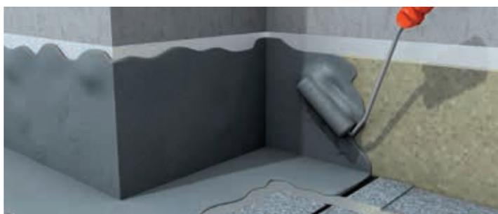
**3.** Nach Aushärtung der Grundierung, Einbettschicht vorlegen. Vor Allem bei Materialübergängen, im Eckbereich oder bei vertikalen Flächen ausreichend Material vorlegen (ca. 1,5 kg/m<sup>2</sup>).
