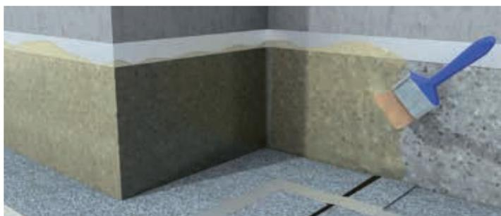
**2.** Fläche im Bedarfsfall gemäß Untergrundtabelle grundieren. Beschichtete Bahnen müssen nicht grundiert werden. Grundierung mittels Roller oder Pinsel, filmbildend auftragen. Nach der Applikation das Abdeckband sofort, im noch nassen Zustand der Grundierung entfernen.
