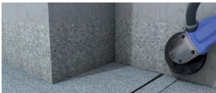
**1.** Vor Beginn der Abdichtungsarbeiten mineralische Anschlussbereiche anschleifen. Lose Schieferschuppen der Bitumenbahn mittels Drahtbürste entfernen. Mit PE-beschichtetem Abdeckband abkleben. Abdeckband auch zur Entkopplung von Fugen oder Materialübergängen verwenden.
