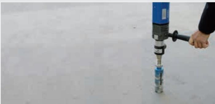
4. Ist der Untergrund in seinem gegebenen Schichtenaufbau **nicht bekannt** bzw. ist z. B. mit Hohlräumen und Feuchtigkeit tiefer im Untergrund zu rechnen, sollten **an definierten Stellen Kernbohrungen** durchgeführt und analysiert werden. Vor Ausführung muss die Lage der Bewehrung durch den Statiker geklärt sein.
