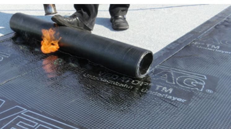
Innovative Direktverlegung mit Vedatop TM
